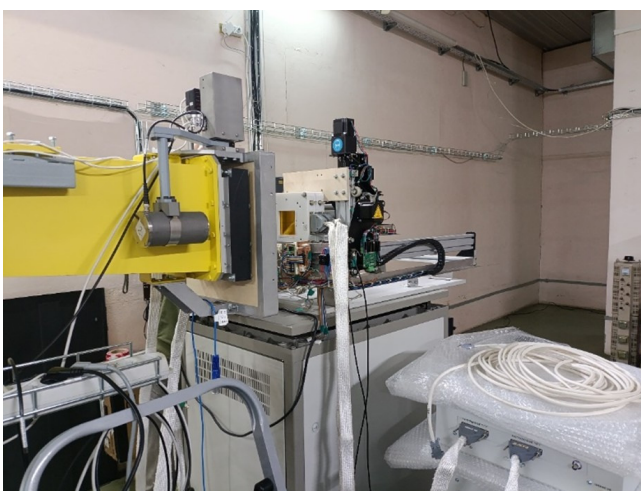
Рис. 9. Подключение ионизационных камер ИК2 и ИК3 к блоку СМПД
