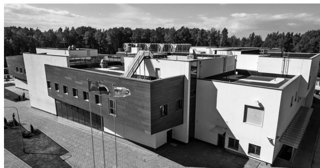
Рис. 3. Центр протонной терапии ЛДЦ МИБС
